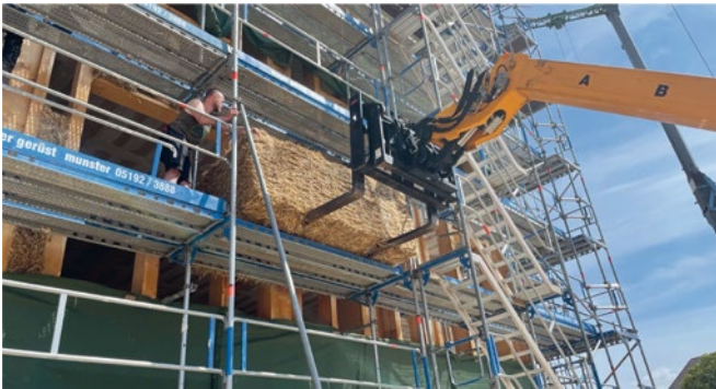
Bild 16 Einbau der Strohdämmung vor Ort
