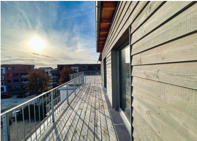
Bild 14 Eine der bewilligten Abweichungen: sägeraue Holzschalung vor lehmverputzter Strohwand
