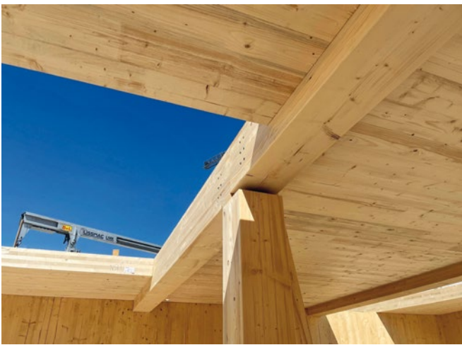
Bild 12 Stütze und Unterzug aus Brettschichtholz, Decke aus Brettspertholz, Stahlteil am Einfeldträgerknoten
