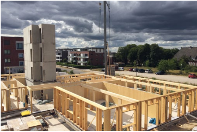
Bild 11 Stahlbetonkern, Holzbau mit tragenden Stützen, Unterzügen und Trennwänden sowie nichttragenden Außenwänden
