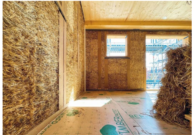
Bild 15 Strohoberfläche innen vor dem Verputzen mit Lehm
