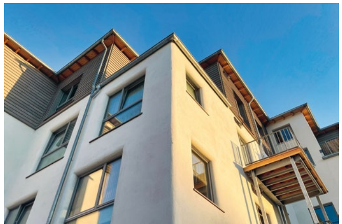
Bild 4 Wohnanlage querbeet : vorgehängte Rinnen, Dachüberstand, gerundete Ecken und Laibungen
