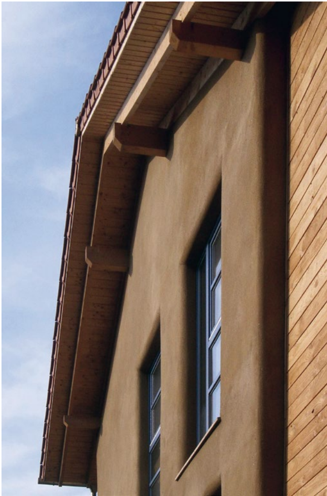
Bild 2 Dreigeschossiges, strohgedämmtes, lehmverputztes Wohnhaus Strohpolis im Ökodorf Sieben Linden
